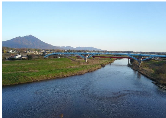
水道管がかかる小貝川黒子橋付近
