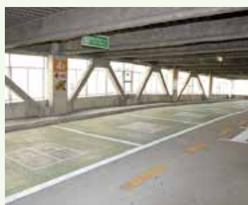
▲立体駐車場各階のスペース
