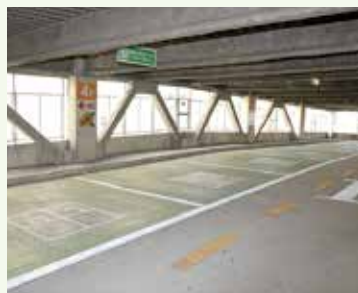
▲立体駐車場各階のスペース
