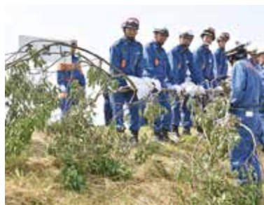
▲川に投入した樹木の抵抗力により、急流部において流水を緩和し、堤防が崩れるのを防ぐ「木流し工法」
