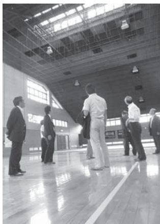
福祉文教委員会現地視察 (明野武道館天井改修工事)
