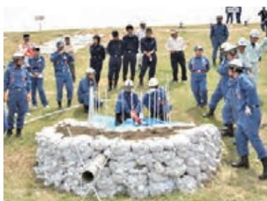
▲堤防から水が漏れた際の対策として土のうを月の輪上に積み上げる「月の輪工法」
