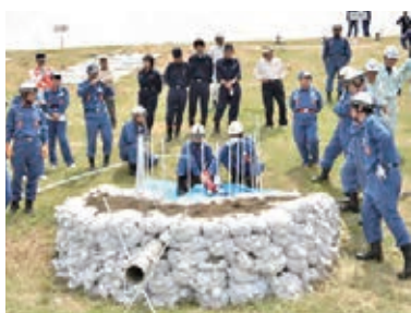
▲堤防から水が漏れた際の対策として土のうを月の輪上に積み上げる「月の輪工法」
