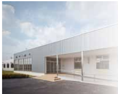
震災後建設された入院病棟
