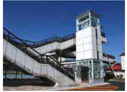
▲ペDESTリアンデッキに設置されたエレベーター（下館駅南口）
