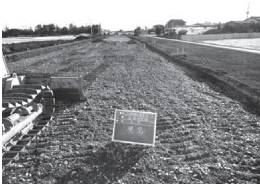
道路改良工事
