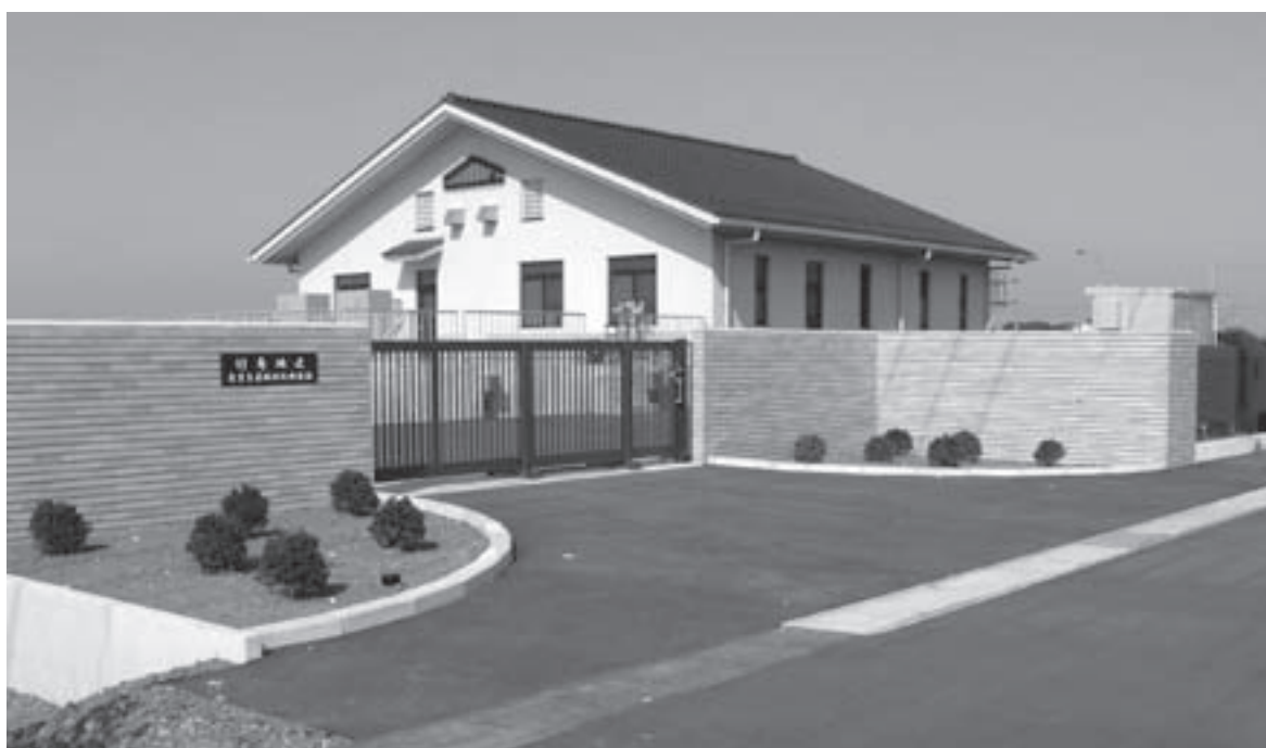
農業集落排水処理場（竹島地区）
