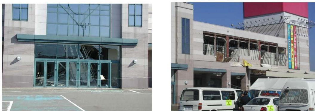
図3-6 天井材・外壁が崩落したRC造大型店舗（中越地震）
