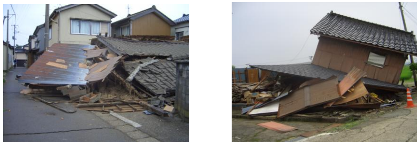
図3-3 木造住宅の倒壊(新潟県中越沖地震の被災例)
