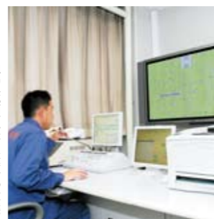
親局 筑西市役所 本庁の放送室
