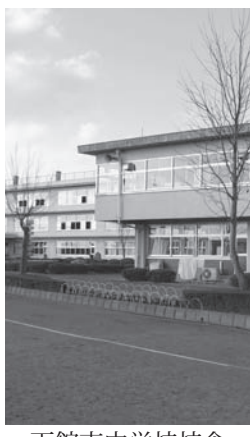
下館南中学校校舎
