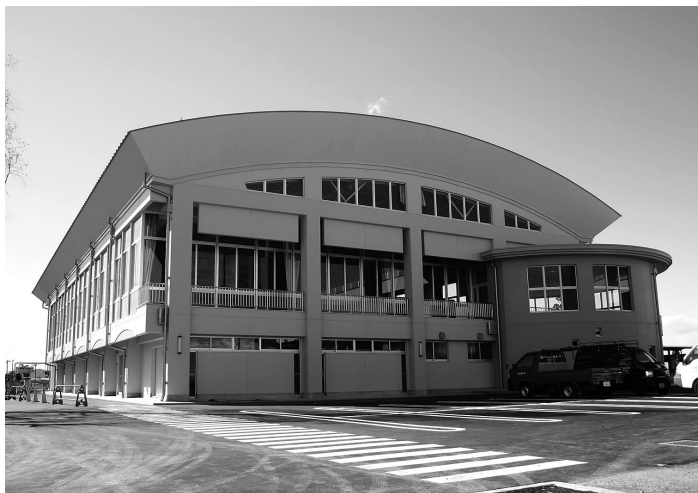
■ 川島小学校体育館
