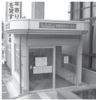
市本庁舎前に設置されている自動交付機
