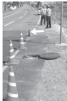
公共下水道工事 (協和地区)
