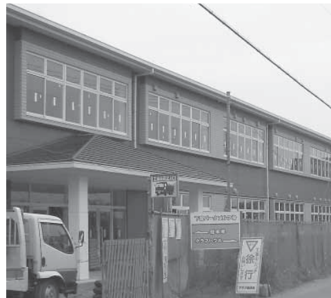
大学新設が望まれる校舎新築工事（茂田地内）
