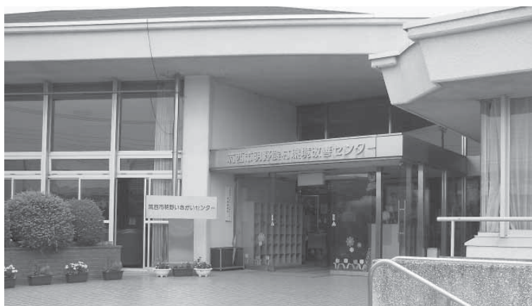
明野農村環境改善センター
