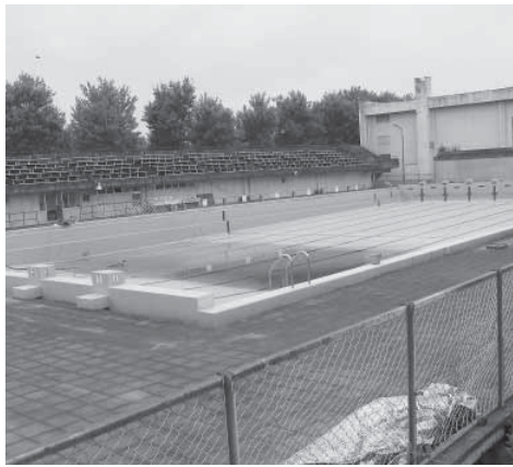
明野中学校プール
