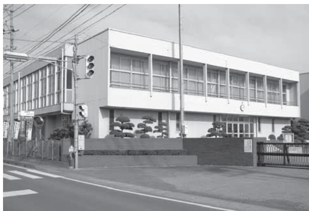
上野小学校体育館
