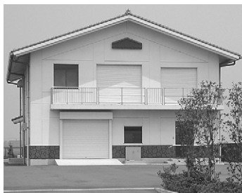
平成16年4月に供用開始された明野西部地区農業集落排水処理施設
