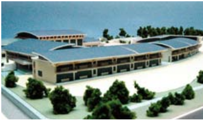
明野中学校校舎の完成模型 総事業費 17億2,021万5千円 鉄筋コンクリート造2階建て 延床面積 7270㎡
